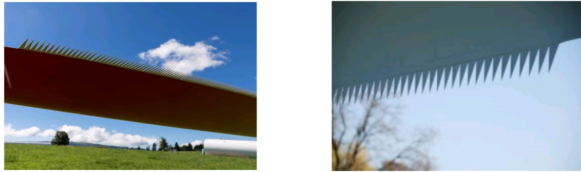
Figure 135 : Photographies d'une pale dotée d'un système STE (peigne / denture)
